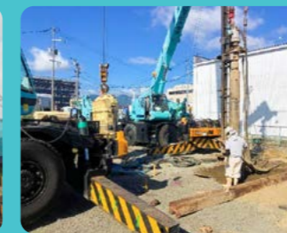
ダウンザホールハンマ工法
