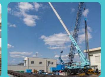
クレーン作業
